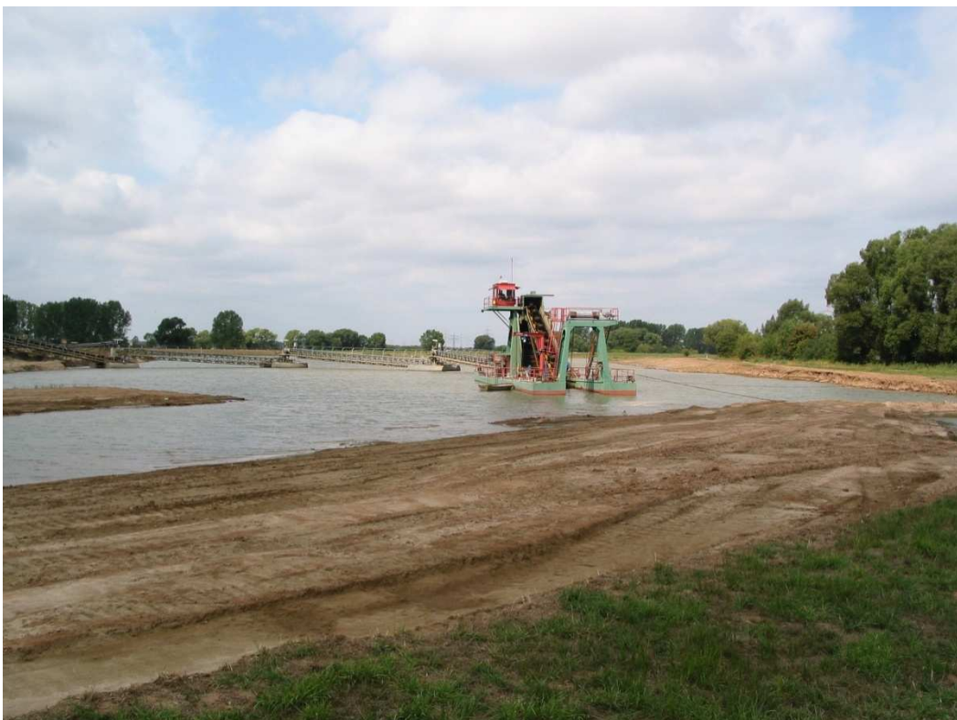
Abb. 5.1.7 Nassabbau von Kies mittels Eimerkettenbagger und Bandstraße im Landkreis Nienburg.
