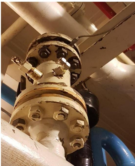
Bild 2 Anschlußarmatur mit abgerissemem Schlauchteil
