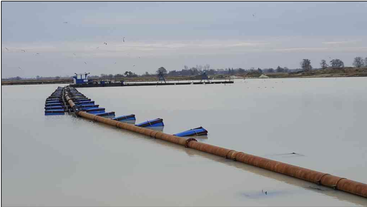
Abb. 9: Saugbagger mit schwimmender Druckrohrleitung
