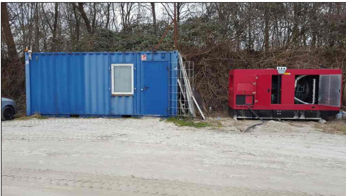
Abb. 7: Container mit Eigenverbrauchertank und Anlagenschaltzentrale sowie benachbartes Stromaggregat/ Generator
