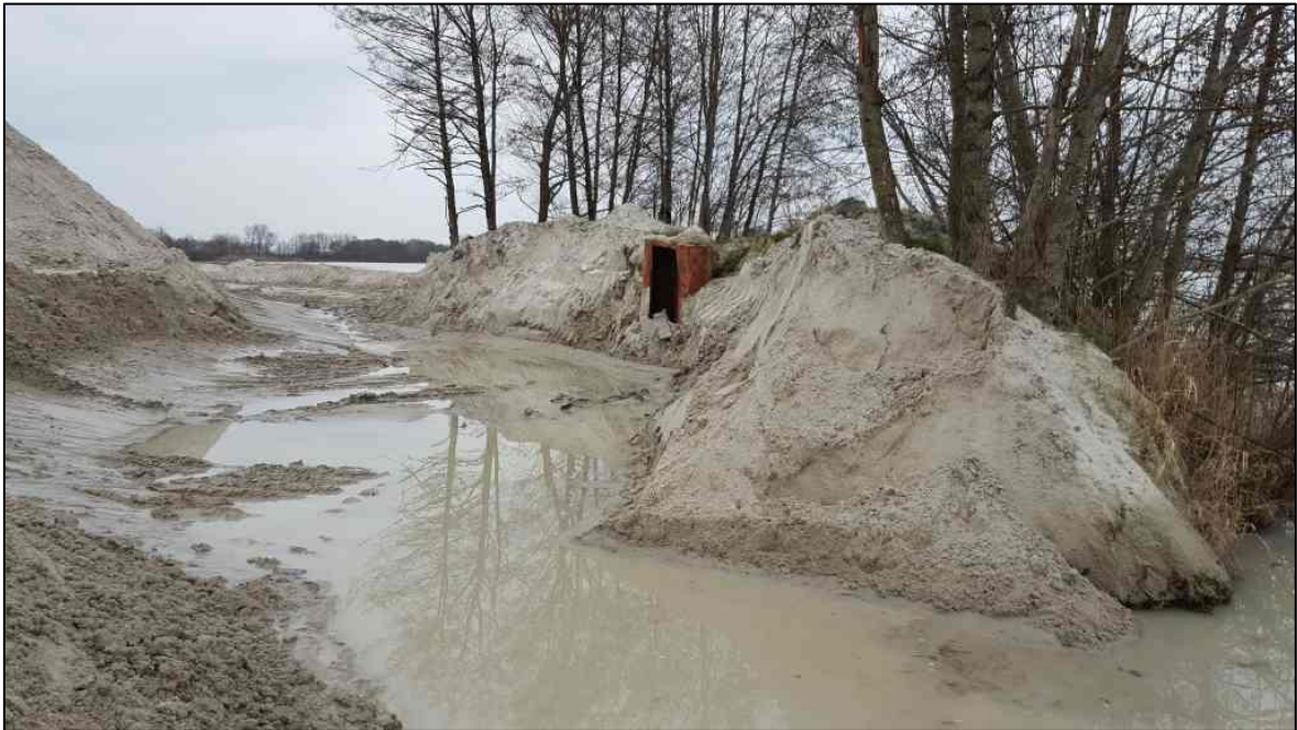
Abb. 11: Schachtbauwerk / Mönch zur Spülfeldentwässerung
