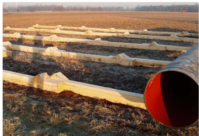
Abbildung 5: Holzbalken zum Lagern der Rohre
