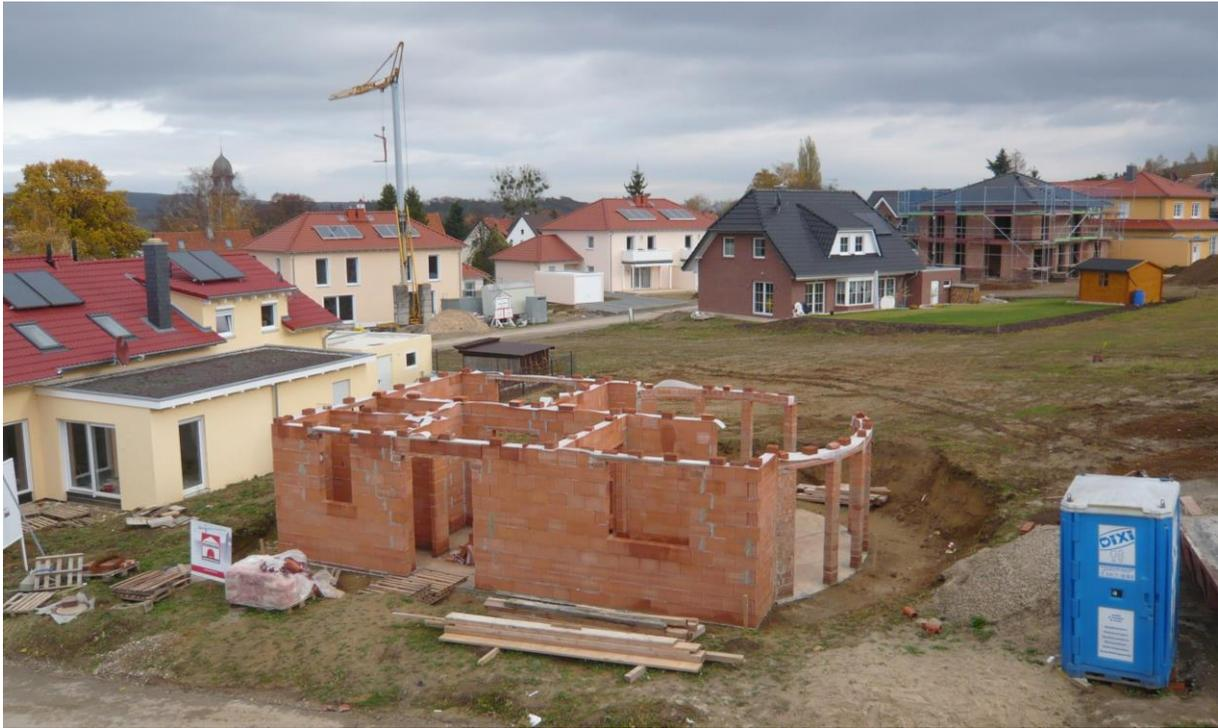
**Abb. 8.1:** Neubaugebiet in Südniedersachsen mit verschiedenen Stadien der Fertigstellung von Ein- und Zweifamilienhäusern. Freiheitsgrade in den Bebauungsplänen erlauben unterschiedliche bauliche Umsetzungen. Davon unberührt bleibt der Gesamtbedarf an Steine- und Erden-Rohstoffen bei Massivbauweise nach wie vor hoch.
