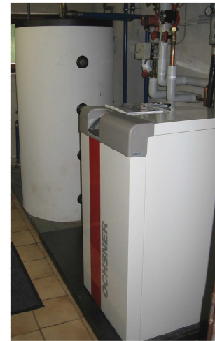
Sole-Wasser-Wärmepumpen
