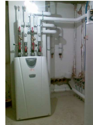
Sole-Wasser-Wärmepumpen
