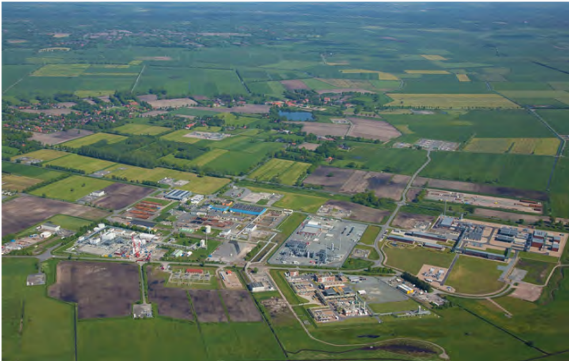
Abbildung 1.1: Übertagebetriebsanlagen des Kavernenspeichers Etzel (Quelle: STORAG ETZEL GmbH).
