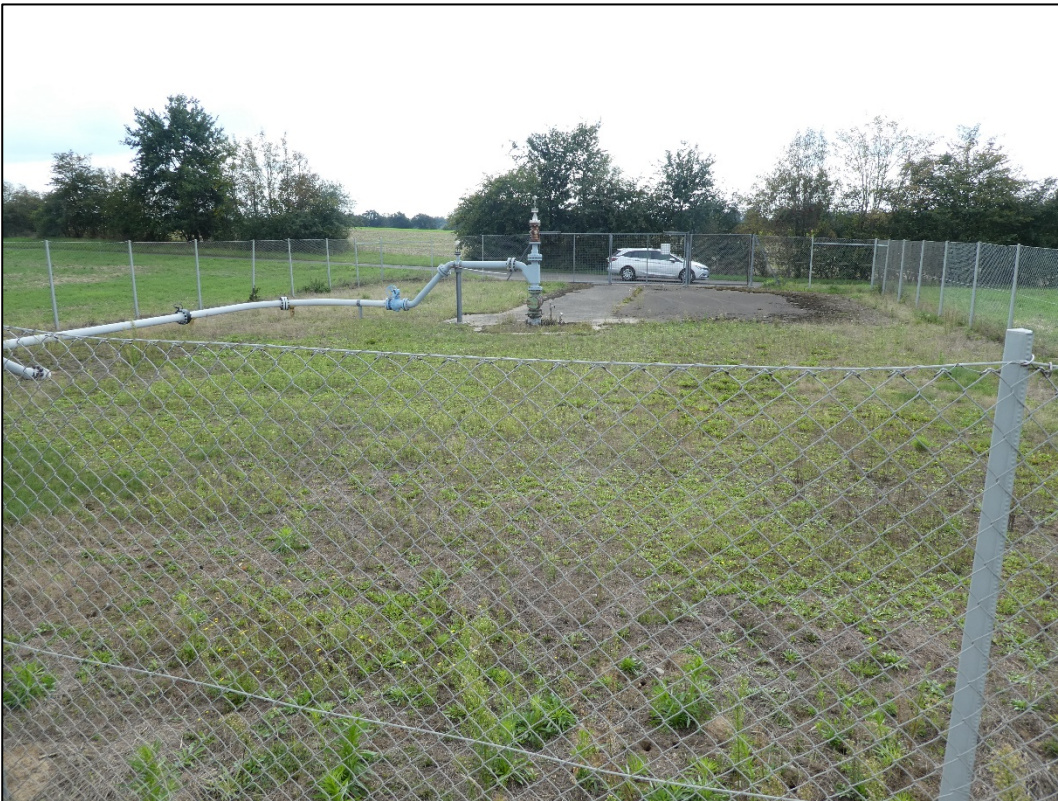
Abb. 11: Eingezäunter Bereich des Platzes Barenburg 6 von Norden gesehen
