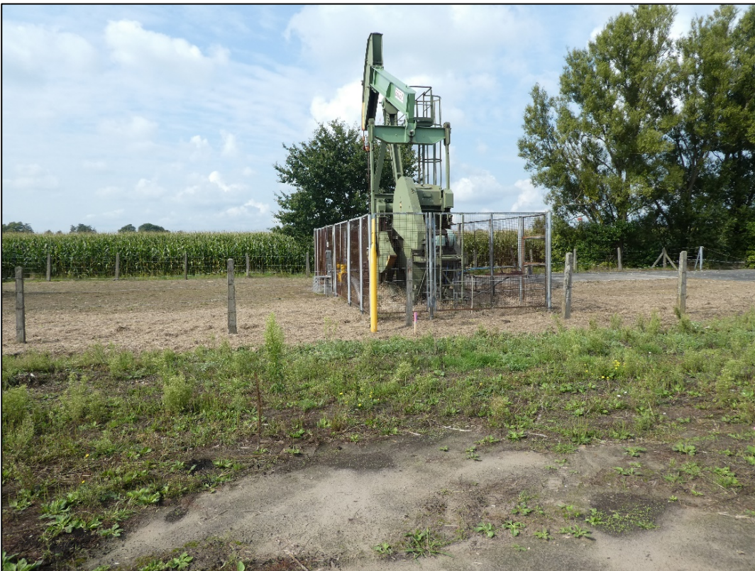
Abb. 13: Ansicht der Pferdekopfpumpe auf Platz Barenburg 20 (Probe BRBG 20/2 links von der Pumpeneinzäunung)
