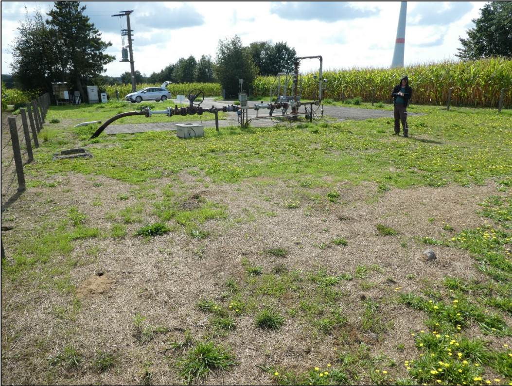
Abb. 10: Ansicht des Platzes Barenburg 4 von Norden
