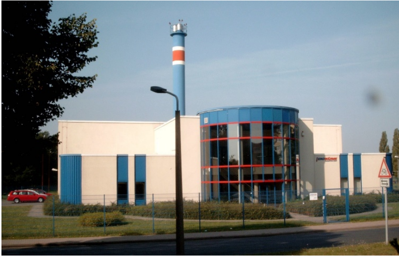
Heizwerk Neustadt-Glewe (MV)
