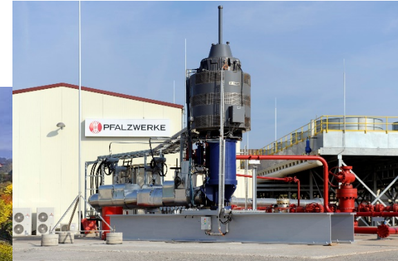
Kraftwerk Insheim (RP) mit Bohrungen +Förderpumpe
