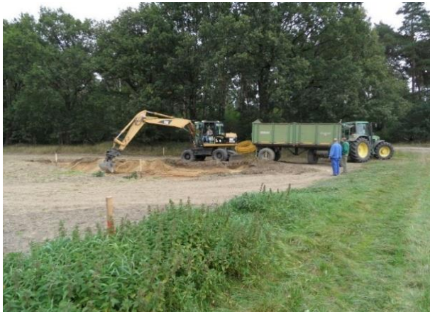
Abb. 5: Errichtung eines Sickerbeckens (Foto: J. Martens, Kreisverband der Wasser- und Bodenverbände, Uelzen)
