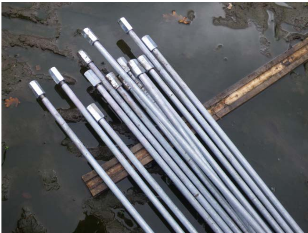
Abbildung 4: Erderstahlstangen für Tiefenerder
