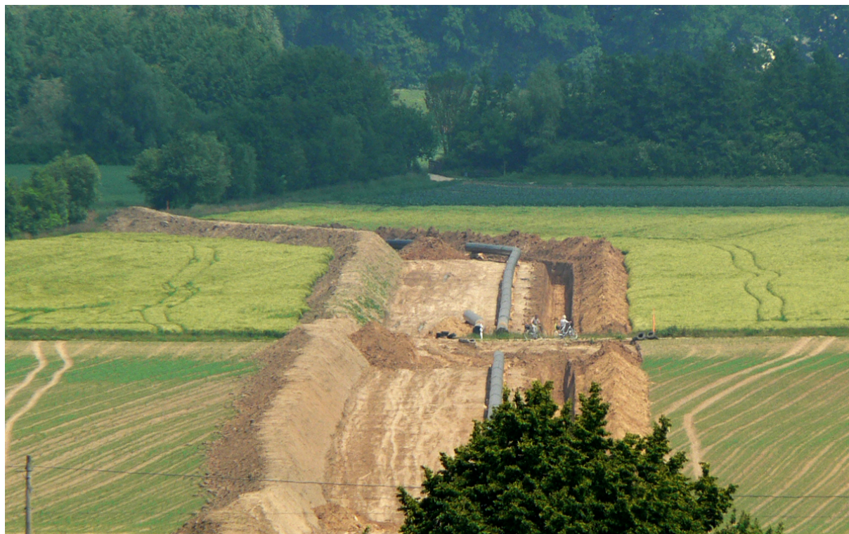
Abb. 3 - Arbeitsstreifen, Rohrgraben und Rohstrang einer Pipelinebaustelle (Foto: Verf.)
