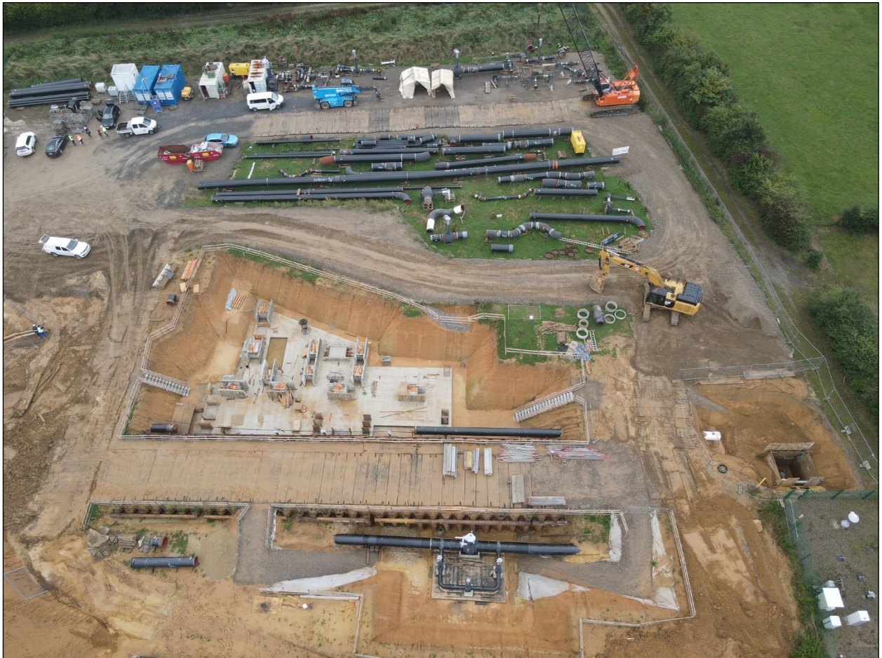
Abbildung 15: Fundamente einer GDRM Anlage
