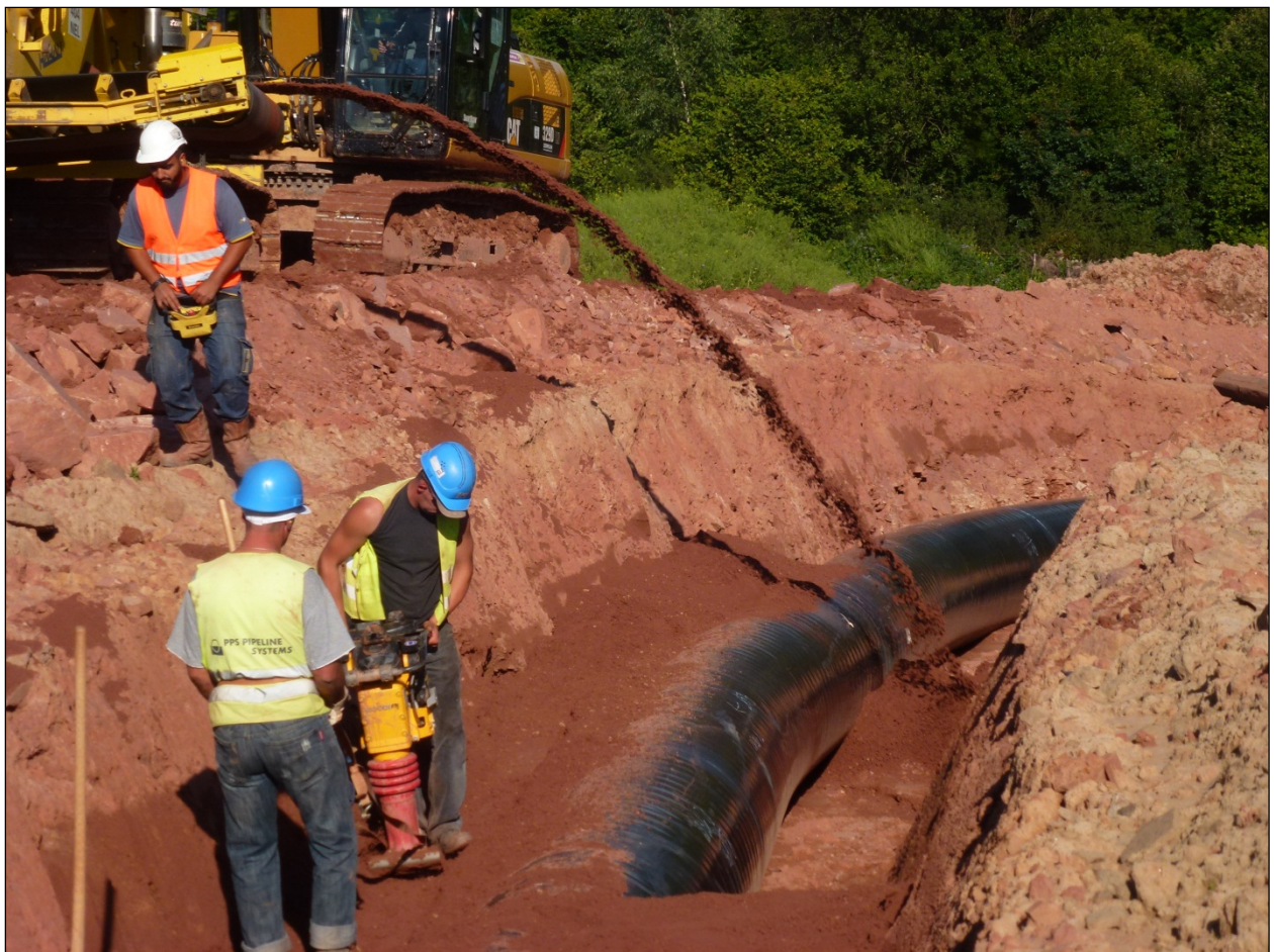
Abbildung 12: Verfüllen des Rohrgrabens
