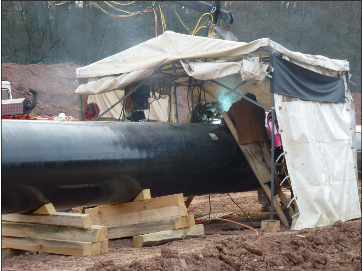
Abbildung 9: Verschweißen der Rohre zum Rohrstrang
