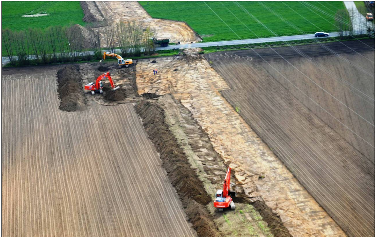
Abbildung 7: Abheben und Lagern des Mutterbodens (Oberboden)
