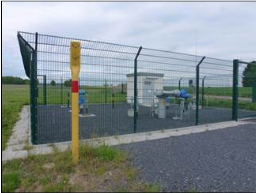
Abbildung 5: Beispiel einer Armaturenstation
