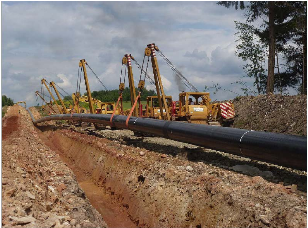
Abbildung 11: Absenken des Rohrstranges
