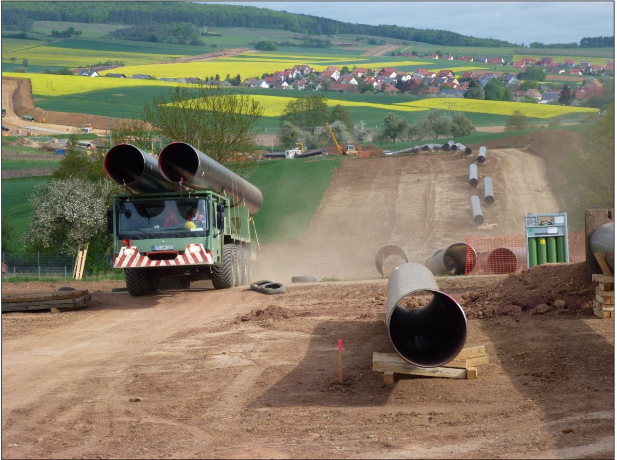
Abbildung 8: Rohrausfuhr
