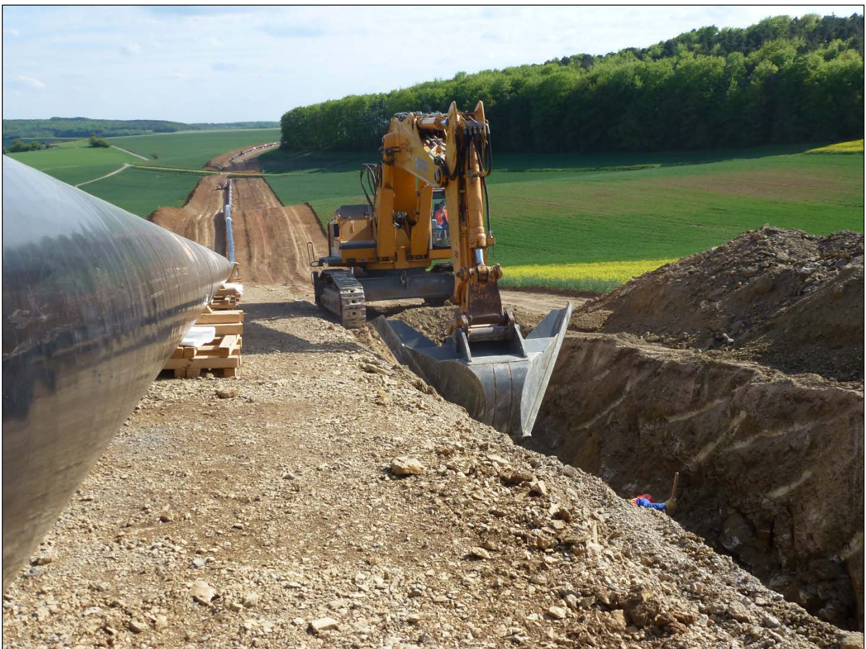
Abbildung 10: Aushub des Rohrgrabens
