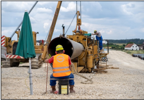
Abbildung 1: Biegevorgang
