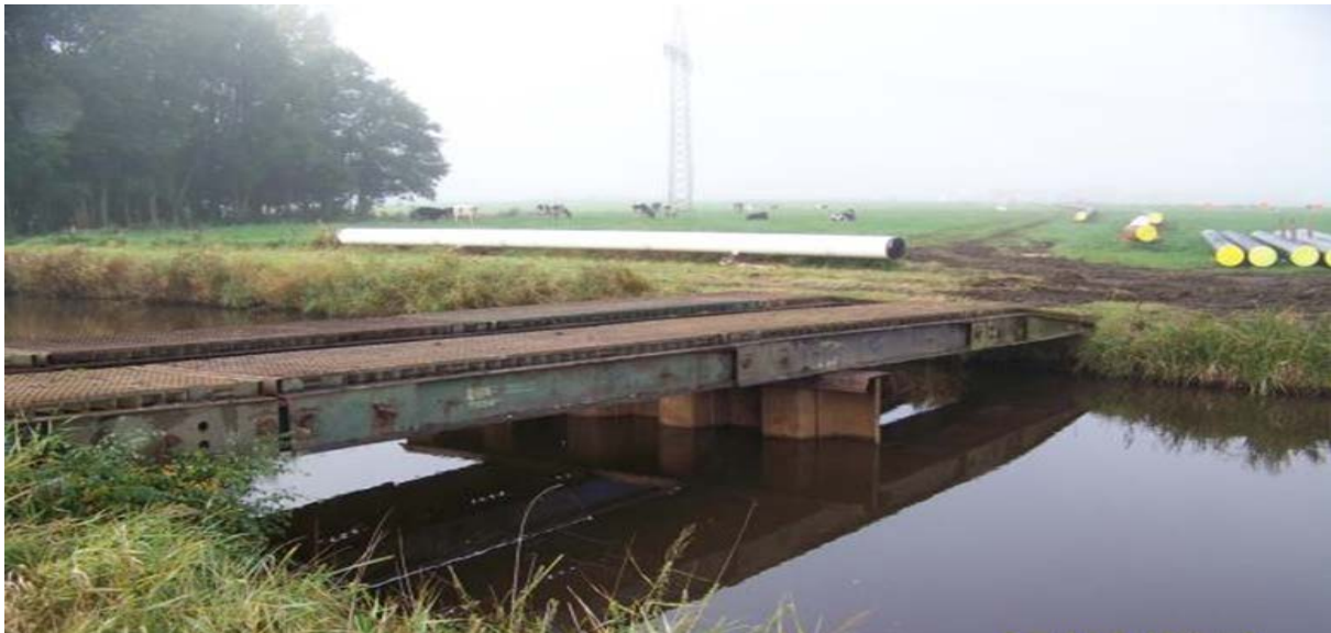
Abbildung 3: Gewässerüberfahrt mittels Hilfsbrücke (sog. Pionierbrücke)
