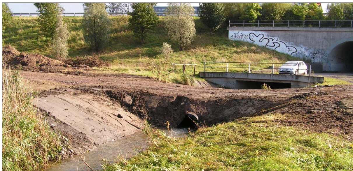
Abbildung 2: Gewässerüberfahrt mittels temporärem Rohrdurchlass
