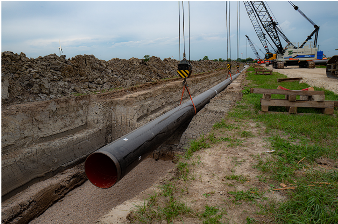
Abbildung 3: Absenken eines Rohrstrangs auf der WAL
