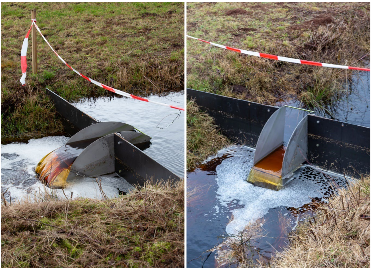
Abbildung 36: Hydraulisch gesteuertes Wehr. Bild links: Hydraulisch gesteuertes Wehr öffnet sich durch den absinkenden Unterwasserspiegel. Bild rechts: Hydraulisch gesteuertes Wehr vollständig geöffnet. Fotos: Dominic Meinardi.
