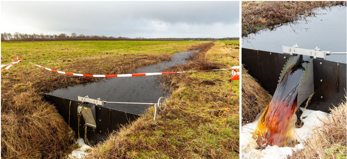
Abbildung 35: Mechanisches Wehr. Bild links: Mechanisch einstellbares Wehr vollständig eingestaut. Bild rechts: Mechanisches Wehr zum Abstau des Grabens geöffnet. Fotos: Dominic Meinardi.
