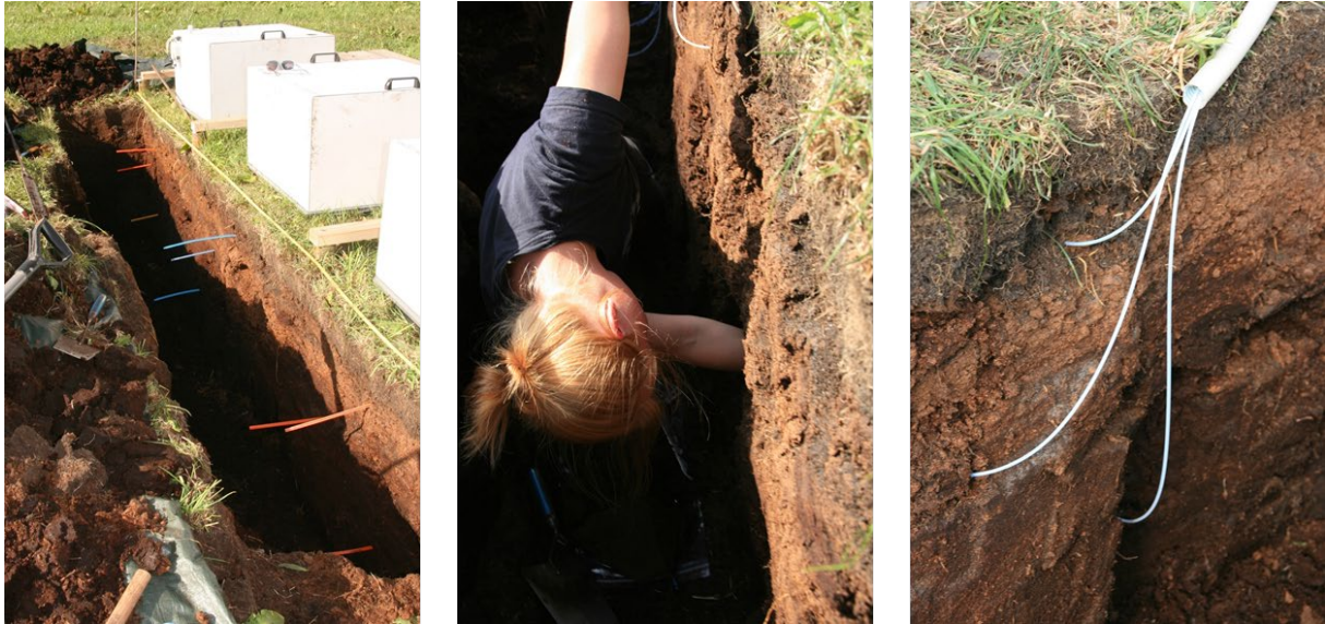
Abbildung 87: Einbau von Saugplatten: Lage der Saugplatten (links), Einbau unter die Rahmen (Mitte), fertig eingebaute Saugplatten und Silikonschläuche zur Beprobung (rechts). Die Bilder wurden bei der Installation am Referenzstandort aufgenommen, Einbautiefen und -methode sind an beiden Standorten gleich.
