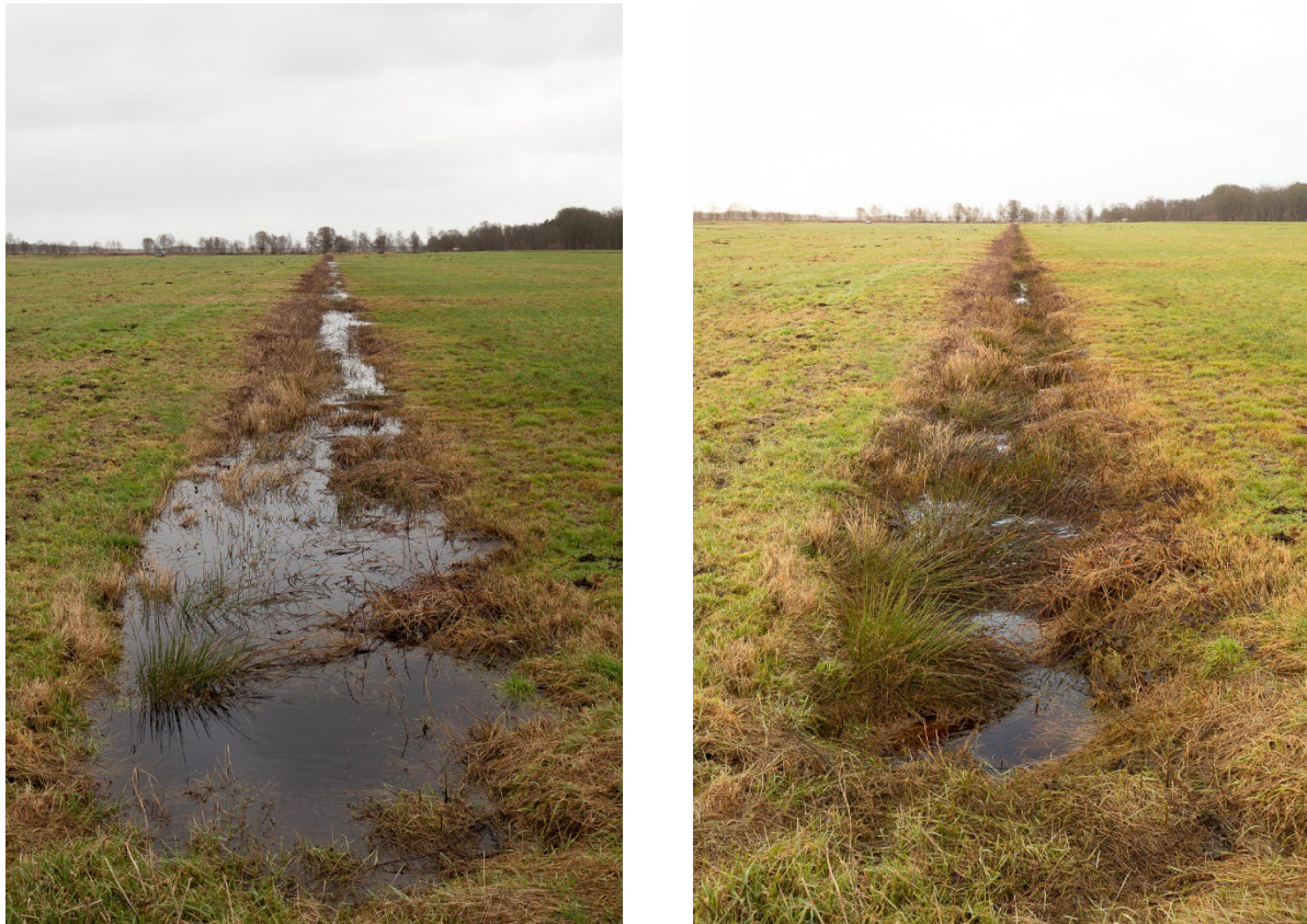
Abbildung 37: Grabeneinstau und Abstau. Bild links: Graben vollständig eingestaut. Bild rechts: Abgesenkter Grabenwasserstand nach Abstau. Fotos: Dominic Meinardi.
