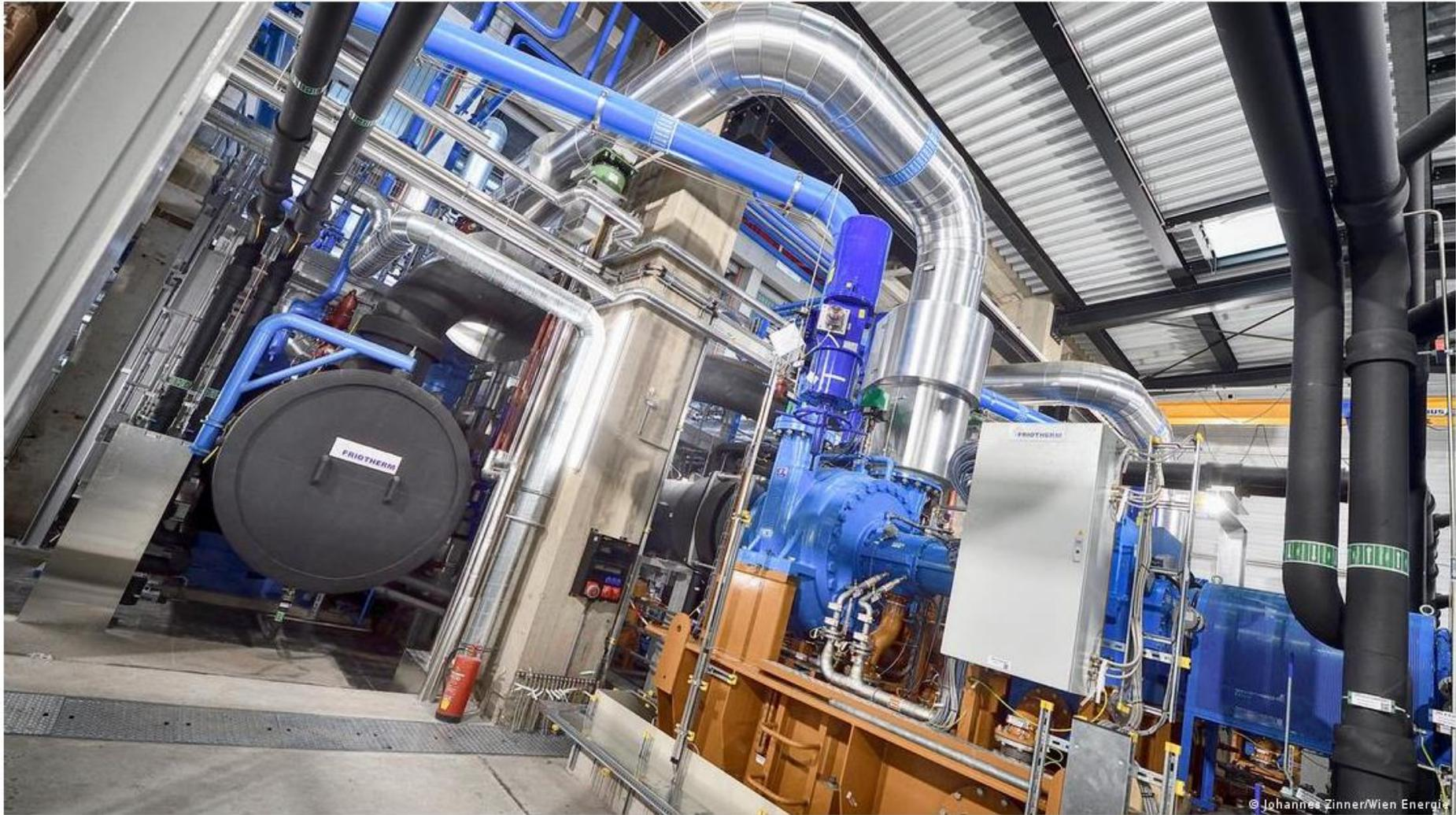
Großwärmepumpe in Wien für 25.000 Haushalte: Sie nutzt die Abwärme von einem Kraftwerk und produziert damit bis zu 95 Grad heißes Wasser für die Fernwärme
