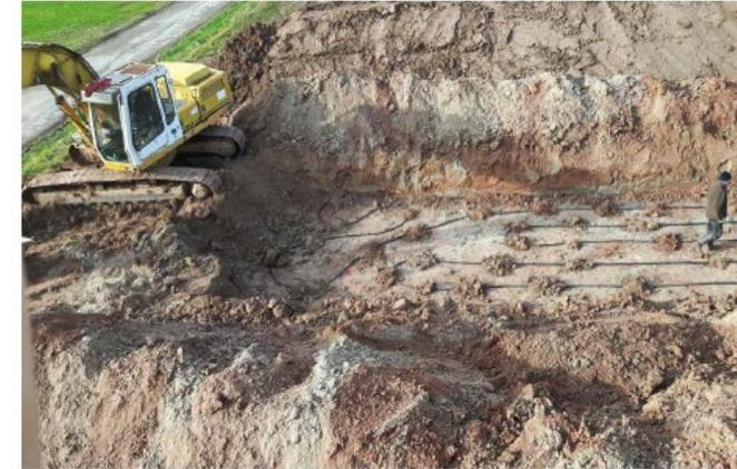
Einbau & Verfüllung mit Bagger
