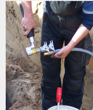
10. Schiebehülsen-Verbindung
