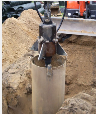
6. Bohren mit Stützrohr
