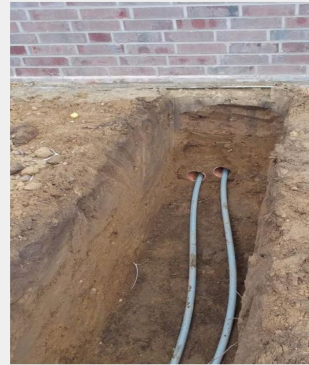
3. Graben für Hausanschluss
