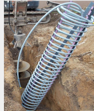
8. Spiralkollektor einsetzen
