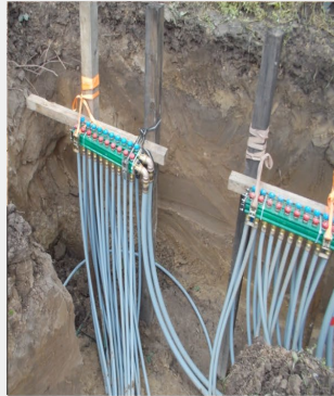
1. Soleverteiler setzen
