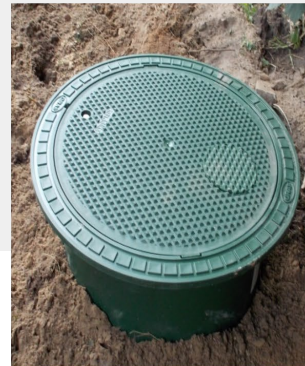
14. Verteilerschacht setzen
