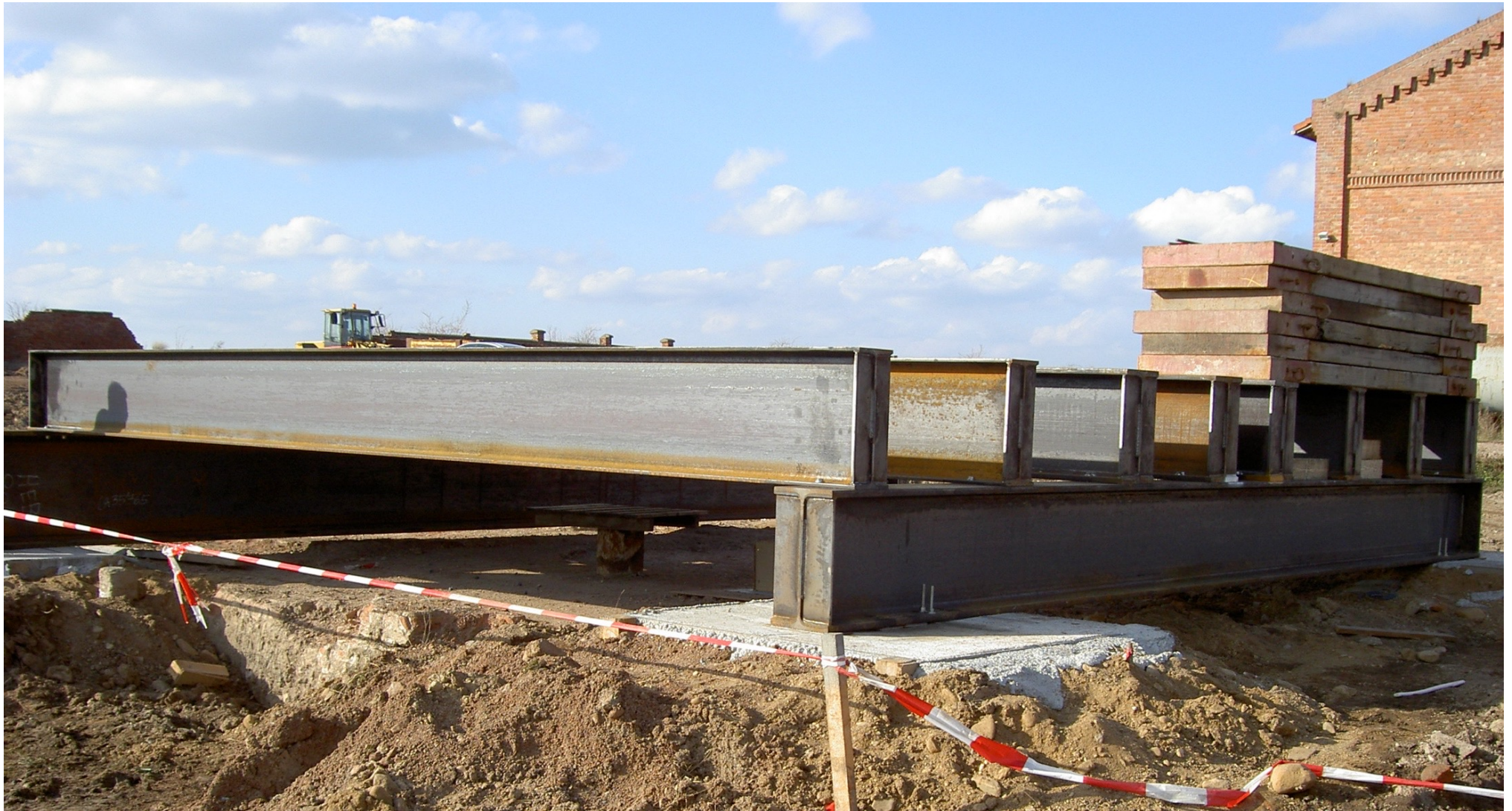
Beispiel eine Bohrbühne
