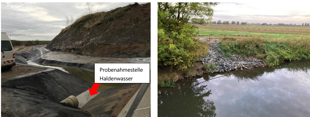
Abbildung 3-3: Sammelbecken Haldenrandgraben mit Probenahmestelle HW (linke Abbildung), Einleitstelle in die Innerste (rechte Abbildung)
