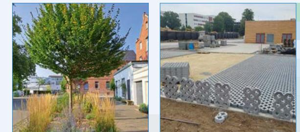
Anlage von entsiegelten Baumbeten (links) und neugestaltete Parkflächen mit versickerungsfähigen Rasengittersteinen (rechts). Fotos: © LBEG.
