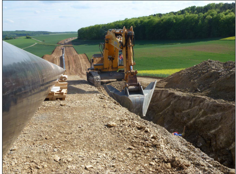
Abbildung 21: Rohrgrabenaushub
