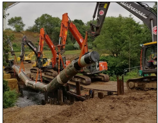
Abbildung 26: offene Gewässerkreuzung mit Trockenbaggerarbeiten
