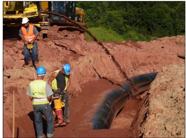
Abbildung 23: Verfüllen des Rohrgrabens
