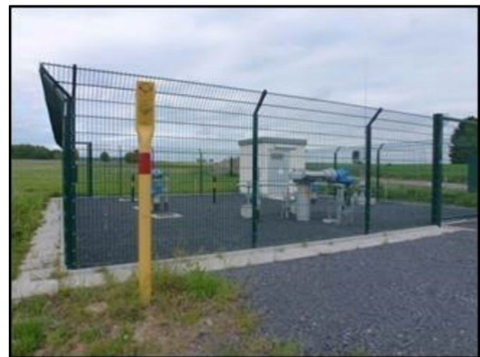
Abbildung 9: Beispielbild einer Armaturenstation mit Übersteigenschutz und Technikcontainer
