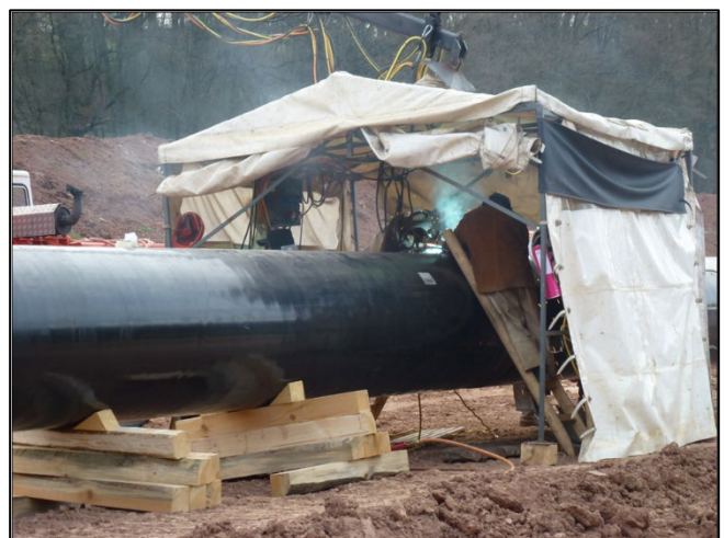
Abbildung 17: Verschweißen der Rohre zum Rohrstrang
