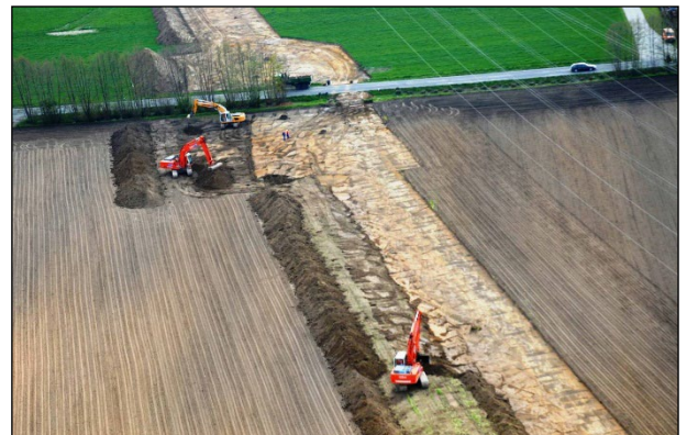
Abbildung 15: Abheben und Lagern des Mutterbodens
