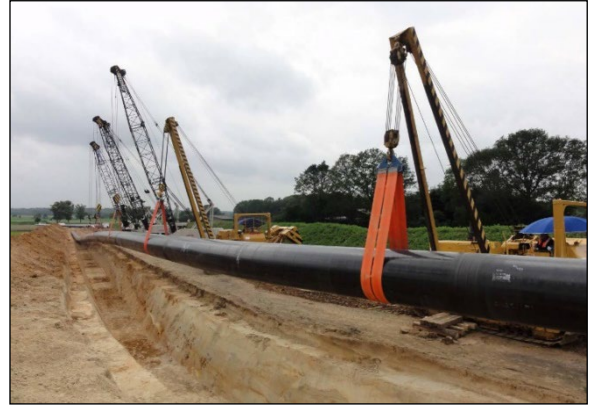
Abbildung 22: Absenken des Rohrstranges mit Seitenbäumen / Rohrlegern und Seilbaggern
