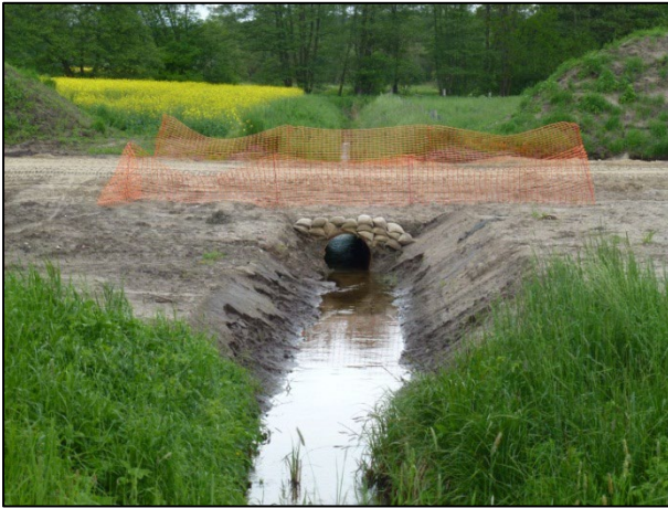
Abbildung 27: Überfahrt über einen wasserführenden Graben - Verdohlungsrohr
