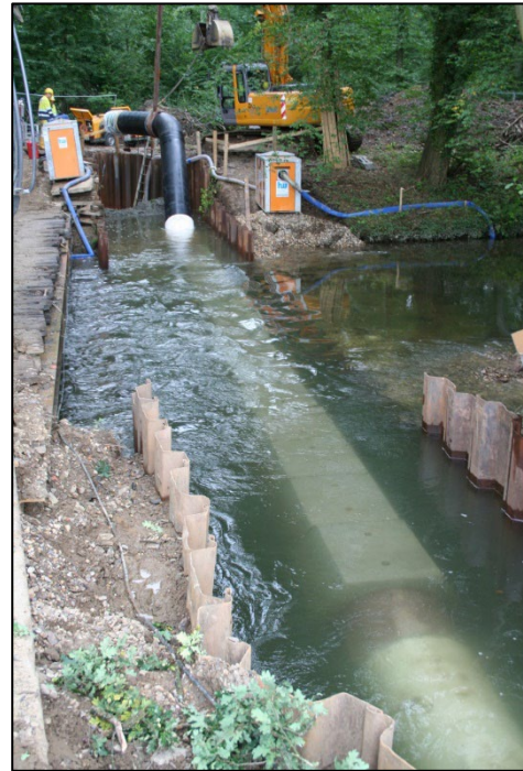
Abbildung 25: offene Gewässerkreuzung mit Nassbaggerarbeiten
