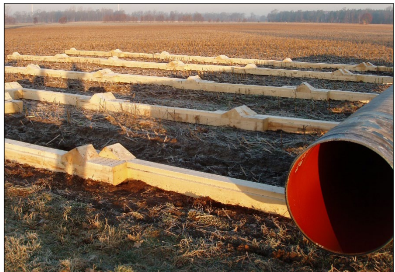
Abbildung 2: Holzbalken zum Lagern der Rohre
