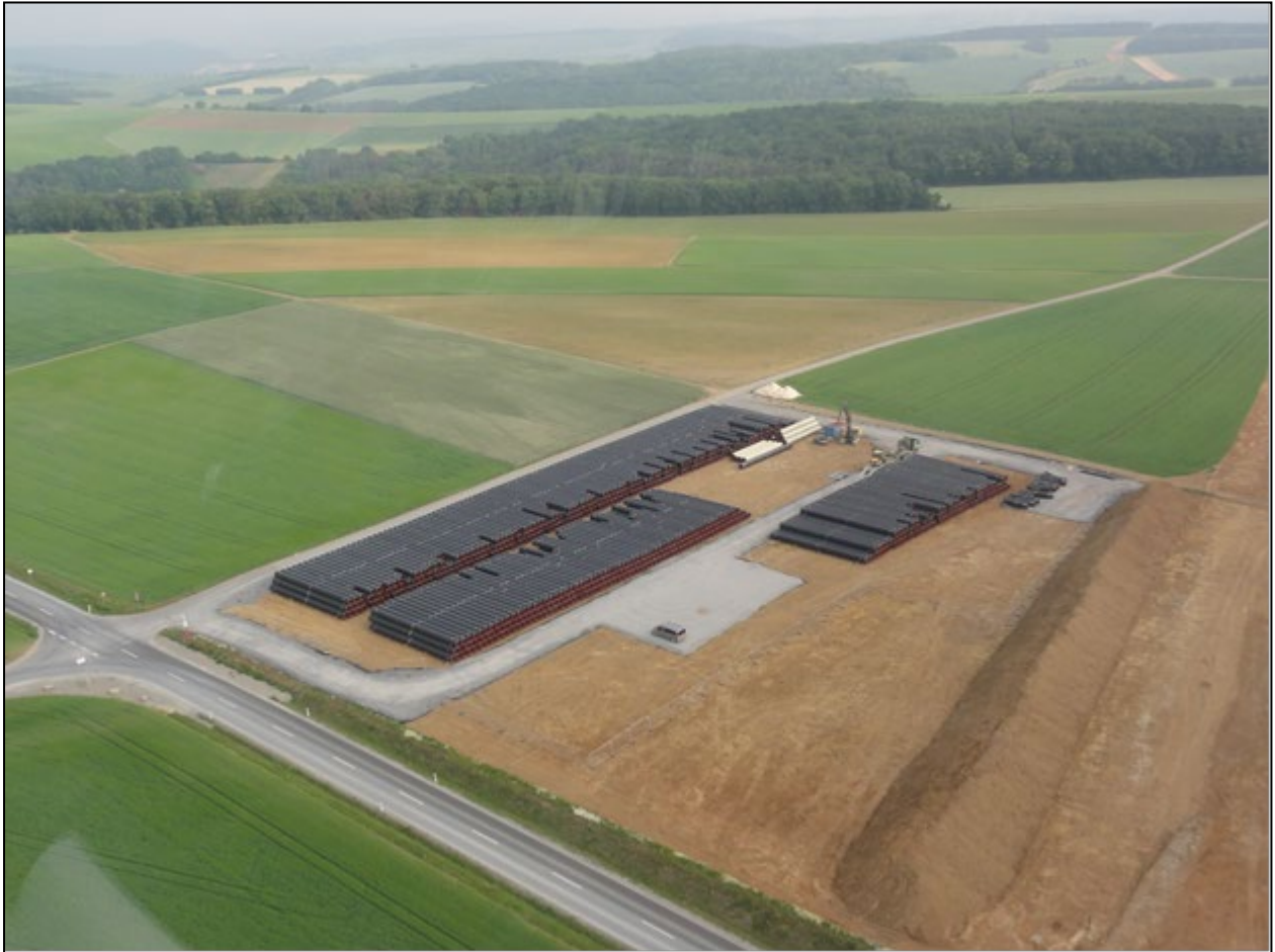
Abbildung 1: Rohrlagerplatz mit Baustraße und abgetragem Mutterboden
