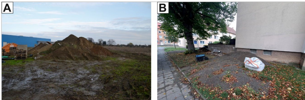
Abb. 28: Beispiele für eine mangelhafte Trennung von Böden und Substraten während Baumaßnahmen (Bildrechte: LBEG).
