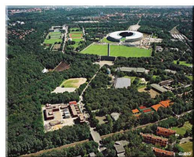
Erdgasspeicher Berlin (Größter Aquiferspeicher Deutschlands)
