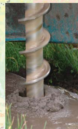
Mit dem Drillbohr- gestänge geförderter Sand mit Kies
