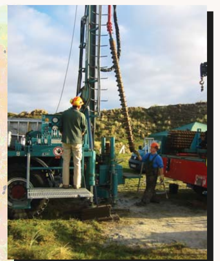
Mobiles Bohrgerät im Einsatz
