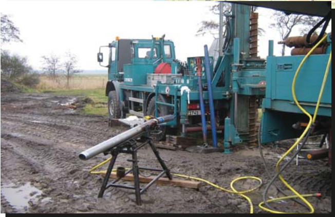
Ausrüstung für Rammkernbohrungen
