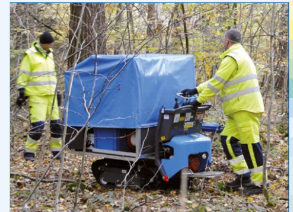
Einsatz in schwer zugänglichem Gelände
