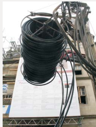
Sole-Sonde aus HDPE
