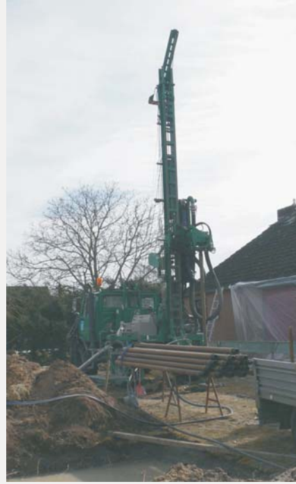
Ansicht eines Bohrplatzes
