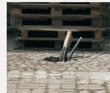
Fertiggestellte Erdwärmesondenbohrung
