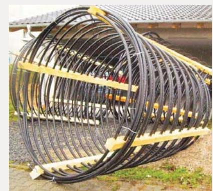
Erdwärmekorb (Spiralkollektor)
