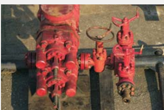
Pumpe für die Zementierung
