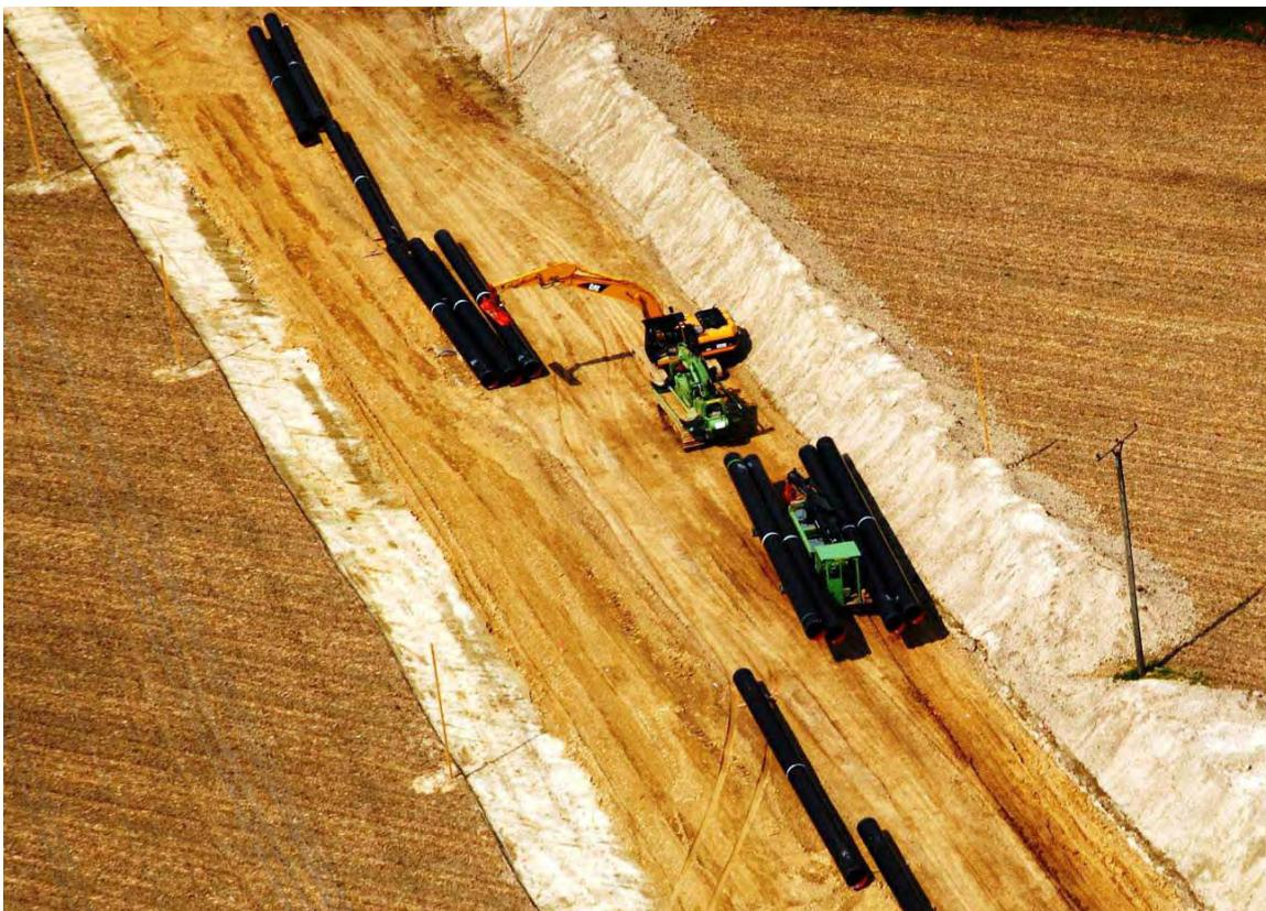
**Abbildung 5: Rohrausfuhr im Arbeitsstreifen**
