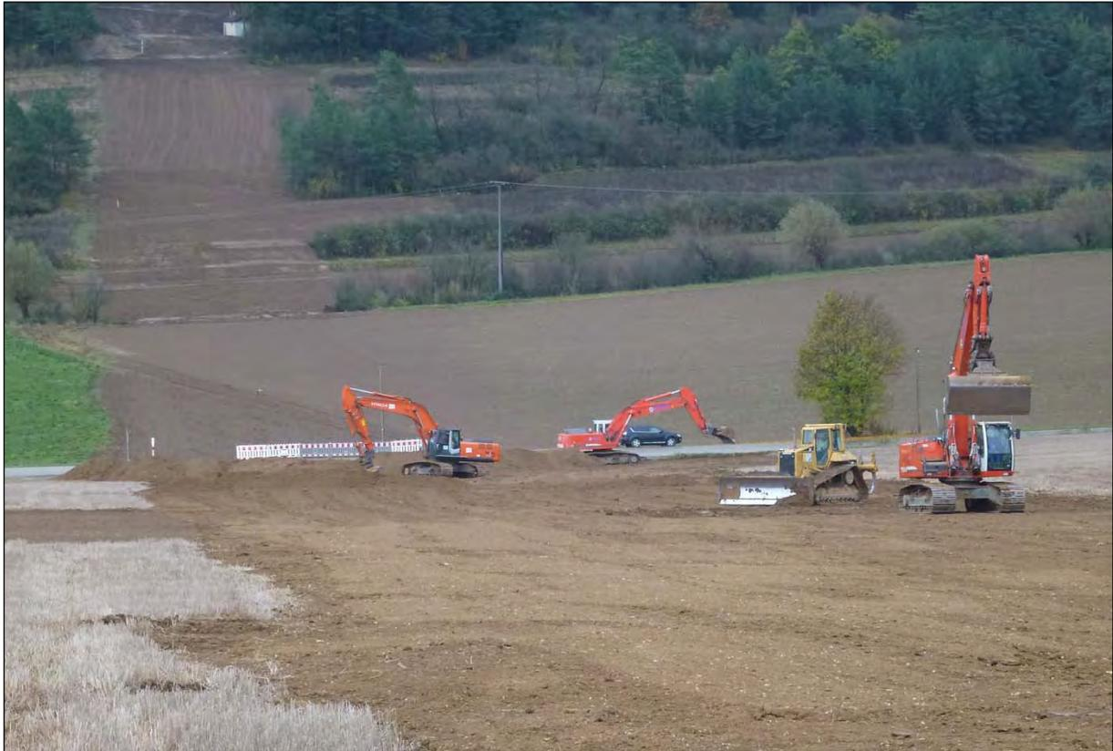
**Abbildung 7: Rekultivierung des Arbeitsstreifens bzw. der Baustelleneinrichtungsfläche**
