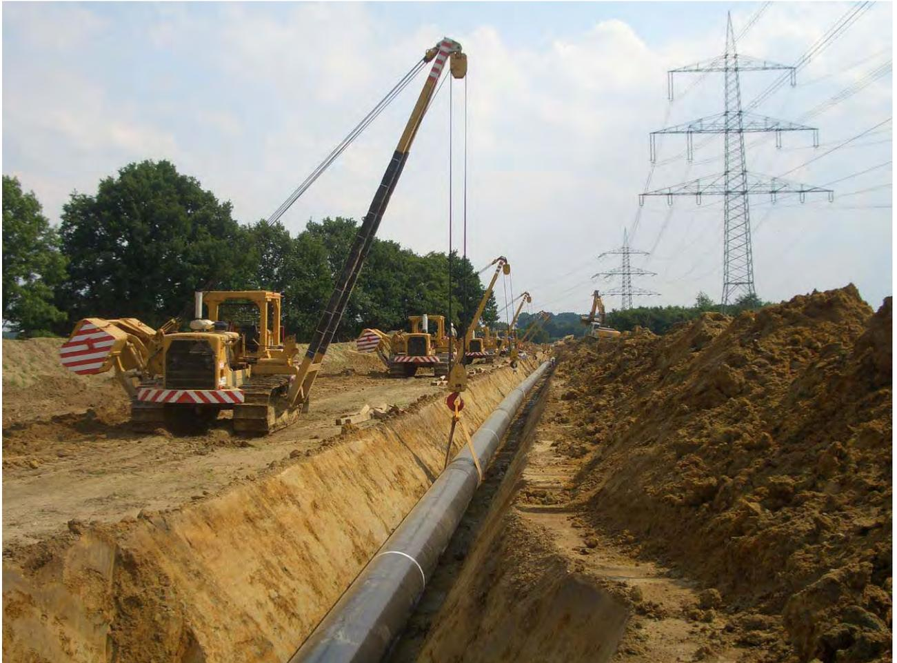
**Abbildung 6: Absenken des Rohrstranges**
