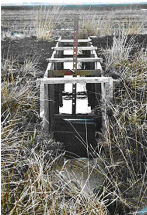
Abb. 9: Regelung der Wasserstände mit veränderbarem Holzstau (J. Blankenburg)
