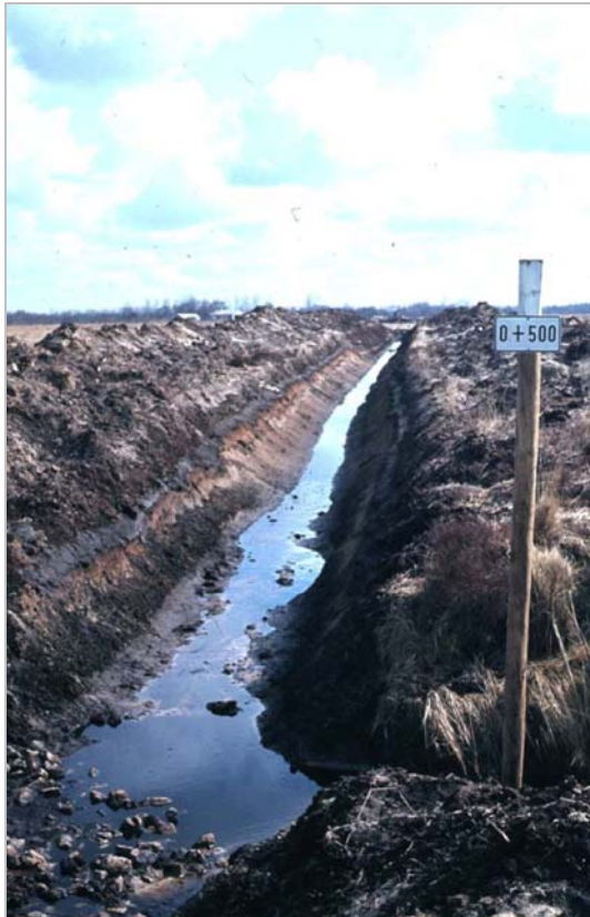
Abb. 7: Säuberung eines Grabens vor der Verfüllung mit Torf
