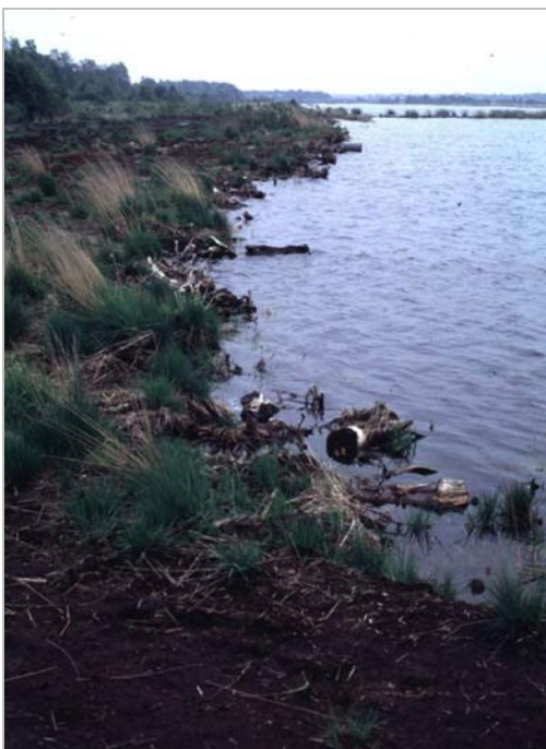
Abb. 6 Schutz gegen Wellenschlag (Bargervehn)
